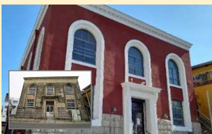
古い公共施設(旧久留米市図書館西分館)を活用した飲食店開業のための外壁改修
